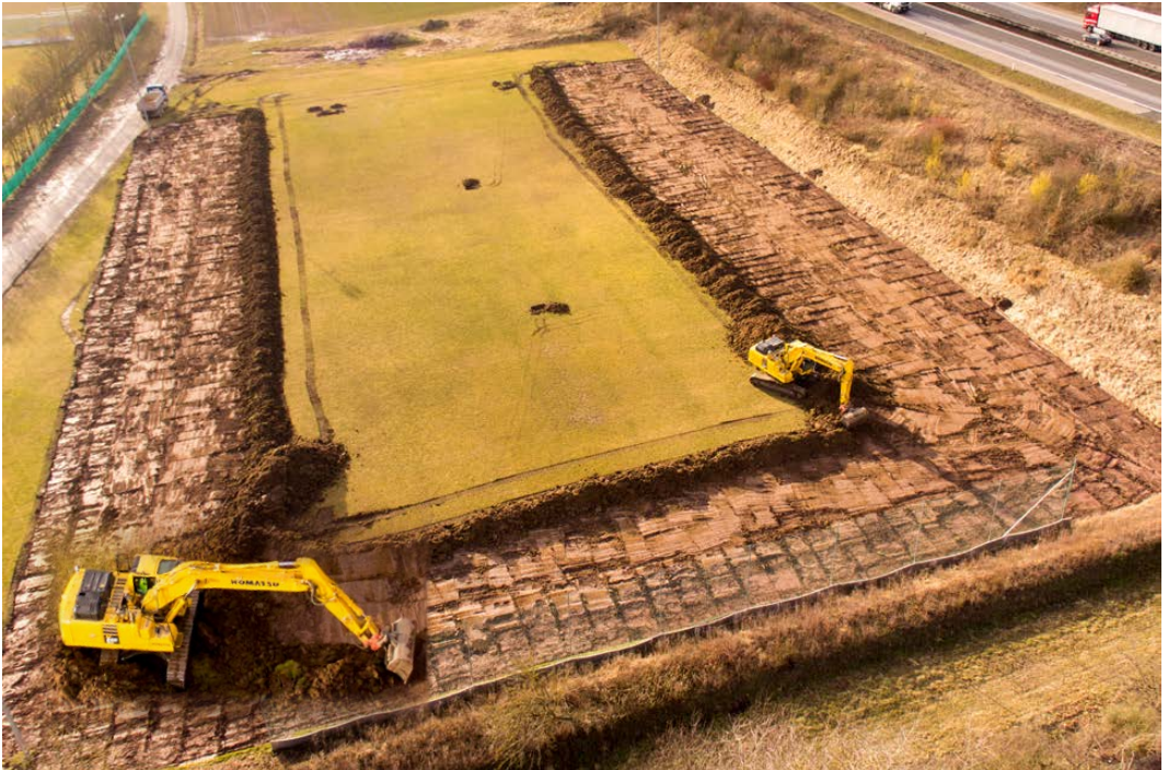
MITTE MÄRZ 2018: Baubeginn, Tag 1: Rolf Tallner entfernt die Grasnarbe hauchdünn vom darunter liegenden Mutterboden.
