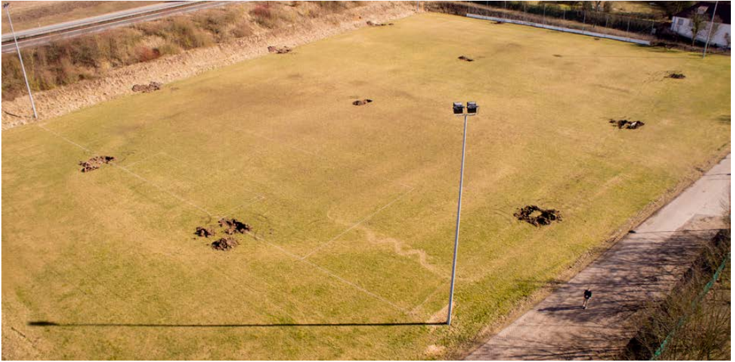
ANFANG MÄRZ 2018: Hier hatten es nicht die Maulwürfe auf unser Trainingsfeld abgesehen, vielmehr wurden Bodenproben genommen sowie die alte automatische Beregnungsanlage demontiert.
